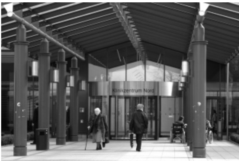
Ganzheitliche Logistik für das Klinikzentrum Nord in Dortmund. Comprehensive logistics at the clinical center Dortmund.
