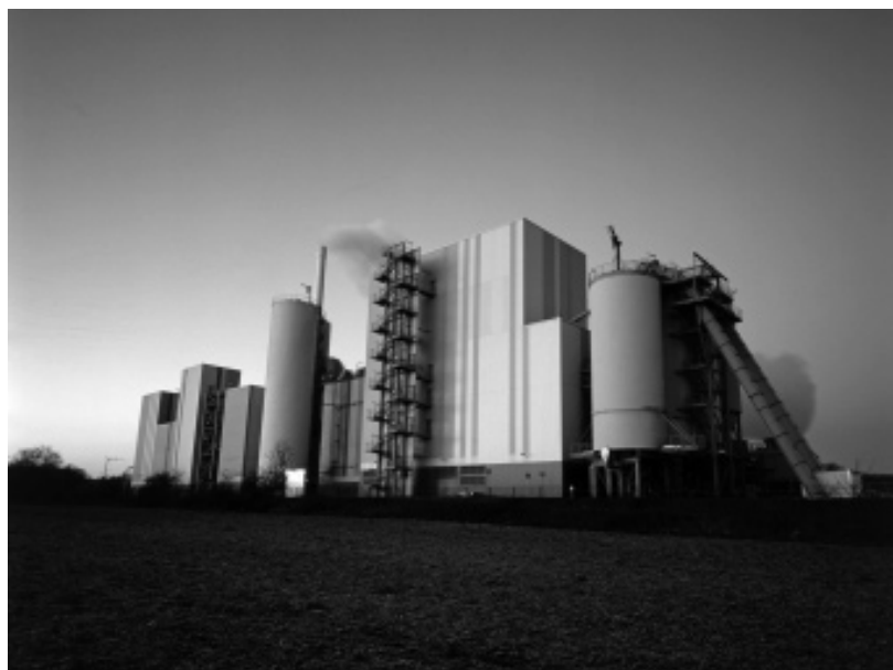
Erzeugung von Strom aus konfektionierten Brennstoffen auf der Basis von Klärschlämmen im Industriekraftwerk der Innovatherm GmbH, Lünen. Generation of power from sludge-based blended fuels in the Innovatherm GmbH power plant, Lünen (Germany).
