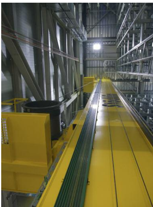
Der Mast des Ein-Mast-Regalbediengeräts Master 24, von unten betrachtet
