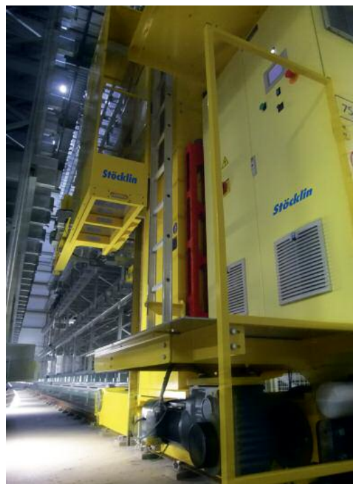
Vollautomatisches Ein-Mast-Regalbediengerät der Baureihe Master 24 mit 18 m Höhe
