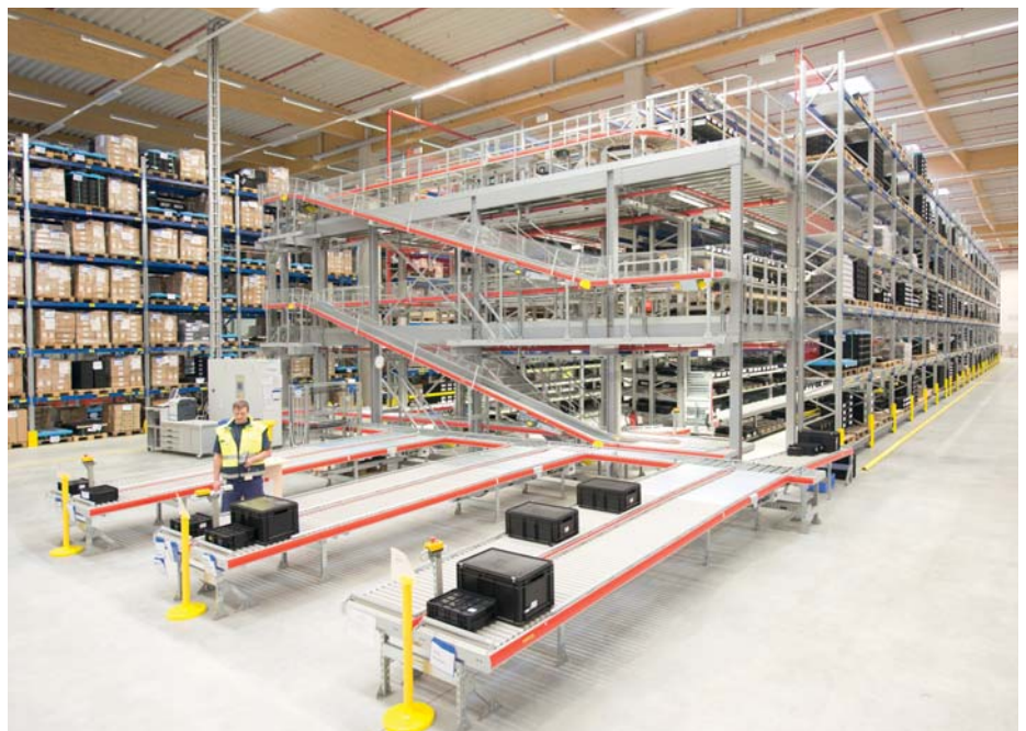
Die Bühnenanlage mit integriertem Kolti-Durchlaufrahmen ist in ein Palettenregal integriert
