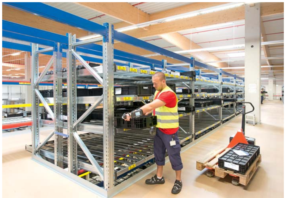
Von der Rückseite aus wird das Kollidurchlaufregal aufgefüllt
